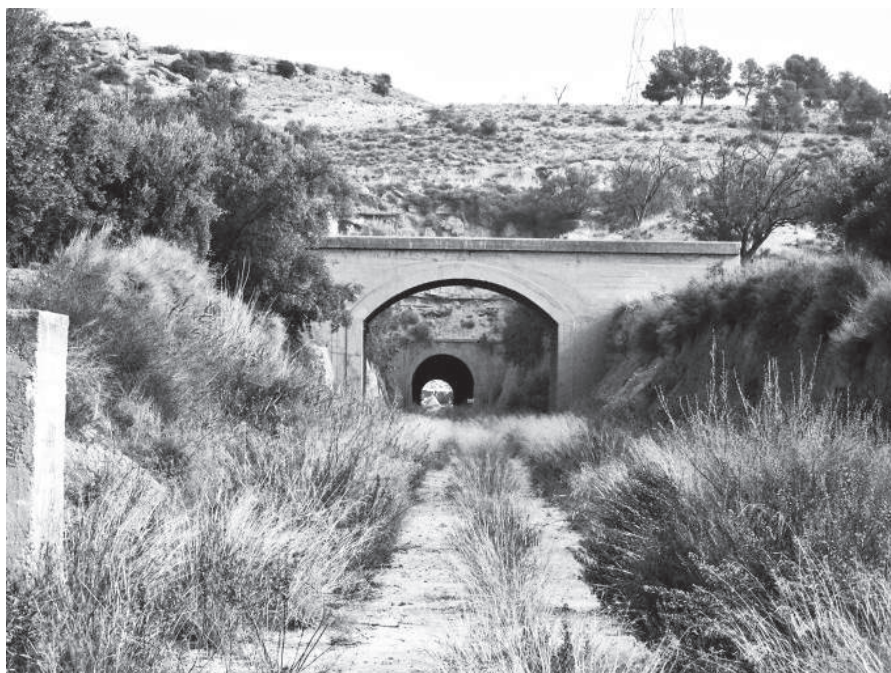
Realización de túneles en el trazado para salvar desniveles.
