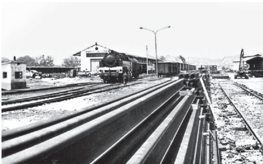
Carril para montaje de vía férrea en Andorra.
