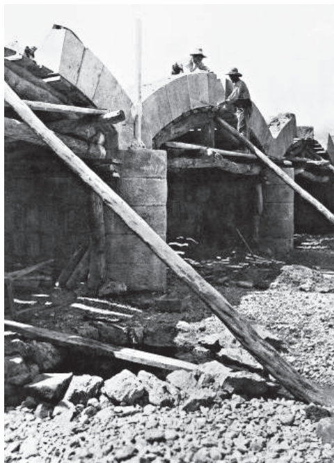
Construcción de puente para trazado de línea férrea.
