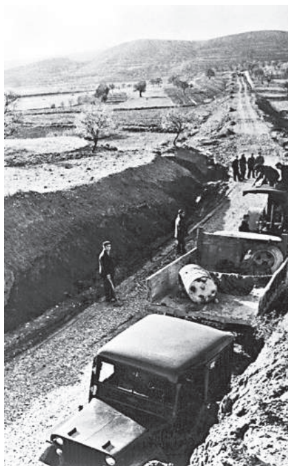
Trabajos para configurar plataforma por donde discurrir el ferrocarril.
