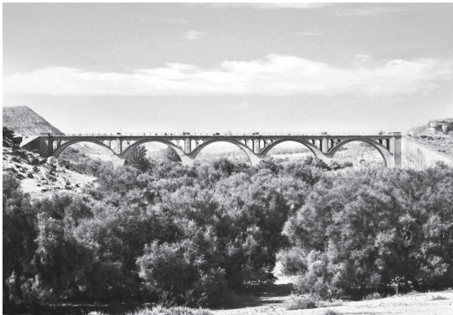
Obra de ingeniería para salvar el cauce del río Martín, puente sobre el mismo.
