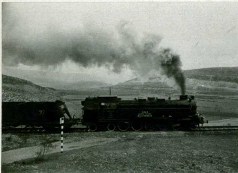
Locomotora "Escatrón" (2-4-2 T), en pleno esfuerzo de tracción, con un tren de tolvas de ENDESA, con destino al cargadero de mineral de este ferrocarril.
