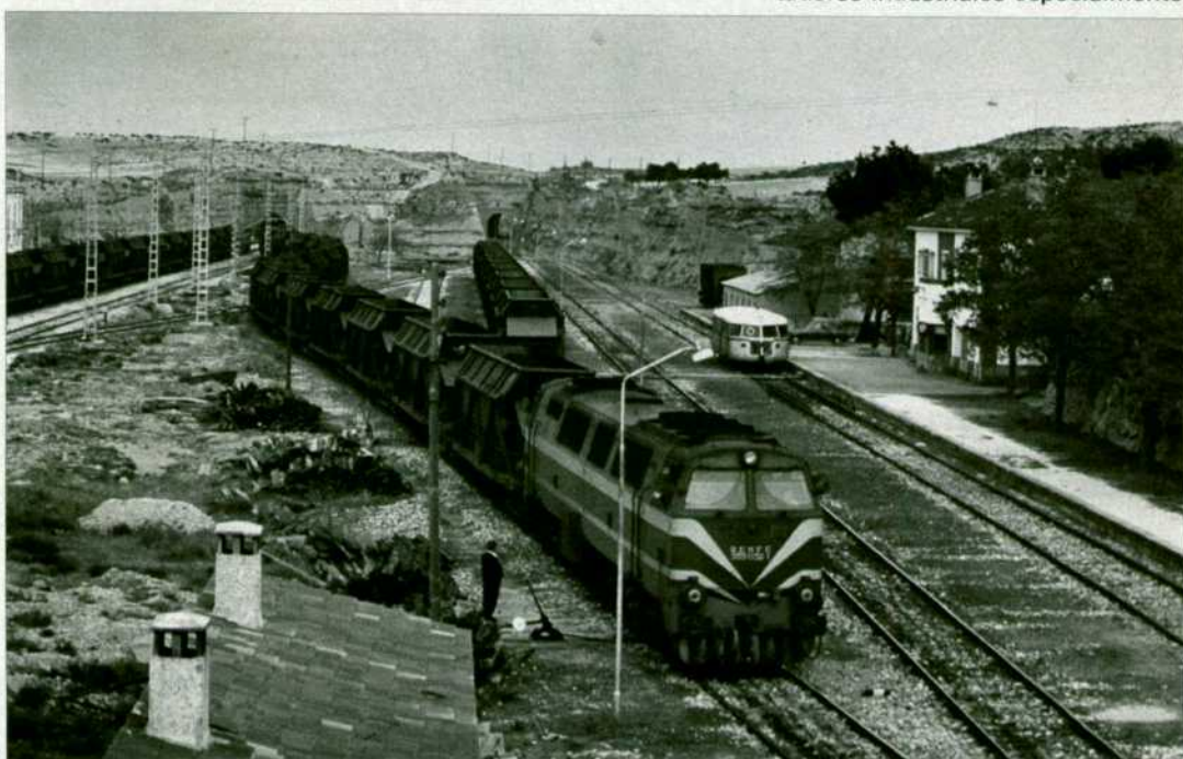
Estación de Samper de Calanda. Locomotora serie 333 de RENFE, entrando en las vías del F. C. de ENDESA, con un tren de 20 tolvas con carbón procedente de Sudáfrica, desembarcado por el puerto de Tarragona.
