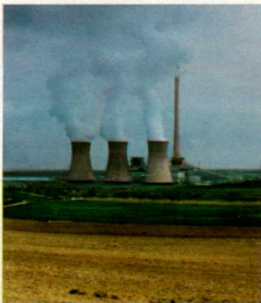
Moderna central térmica en Andorra de Teruel. Posee una potencia de 1.050 Mw. y su nombre es Teruel. Constituye un importante punto de destino del carbón transportado por RENFE y el F. C. de ENDESA.
